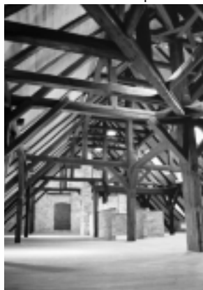
Podkrovný priestor s historickým krovom po obnove v roku 2009.
